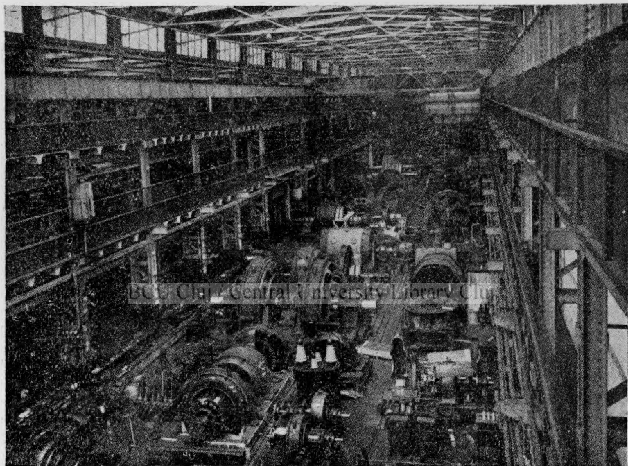
Fig. 3. Sala de montare din Dynamowerk .
