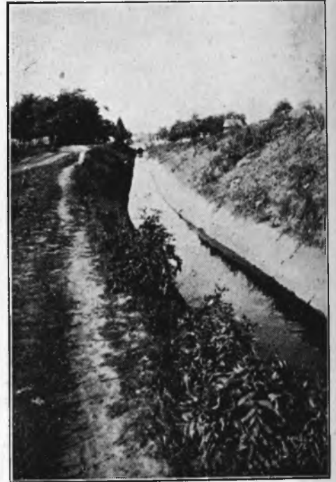
Canalizare în Calafat
