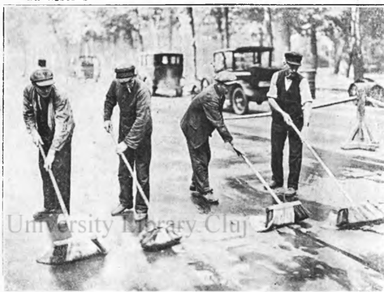
Pentru a evita alunecăturile pe străzile Berlinului, municipalitatea a hotărât pavarea străzilor cu asfalt „grunjos”.
