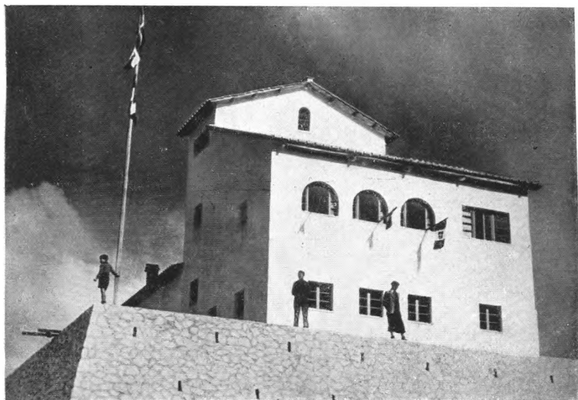
Un aspetto del nuovo villaggio agricolo «D'Annunzio»
