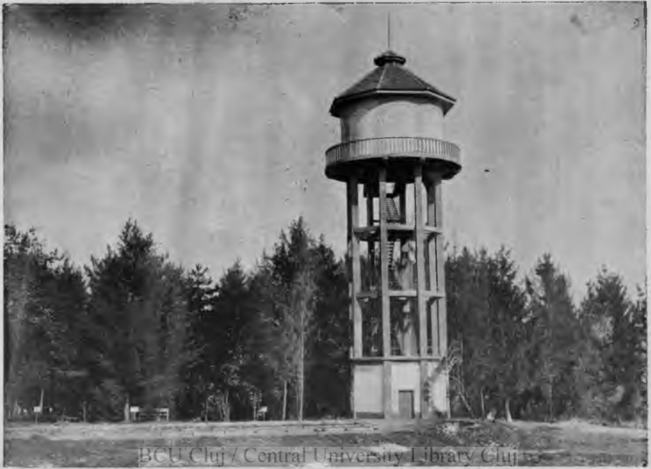
Fig. 5. Castelul de apă. În față bazele de apă în construcție.
