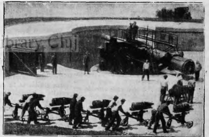
Artileristii americani hrănesc monstrul de 14 țoli așezat pe coasta pacifică a Fortului McArthur de lângă Los Angeles. Fiecare obuz cântărește o tonă (1000 kg.) și golește stomacul la o îndepărtare de 25 mile (40 km.)
