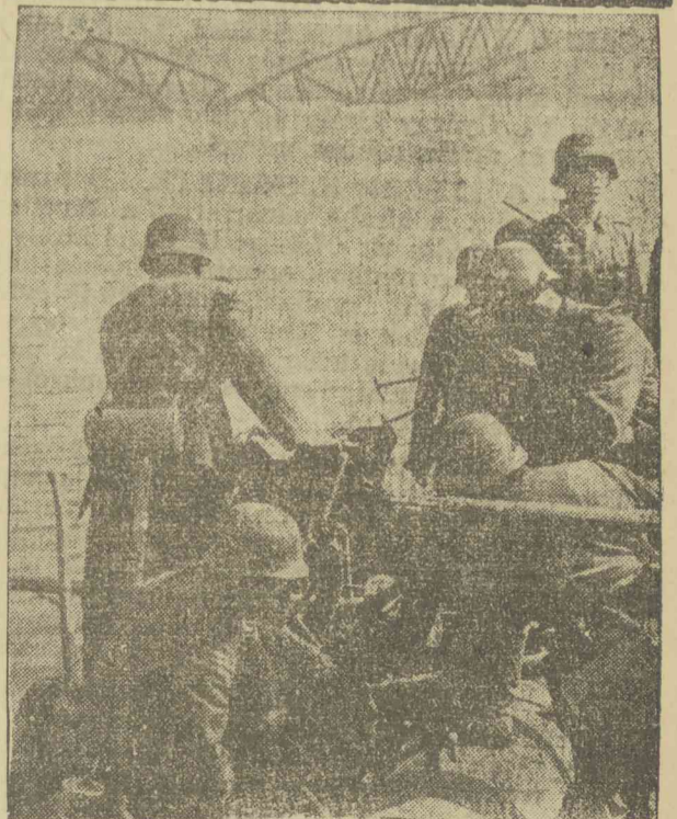
Tankelhárító ágyú átszállítása a folyón, melynek hidját felrobbantották.
