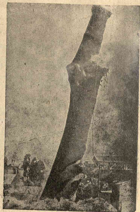
KÉMÉNYDÖNTÉS. Ezt a 80.000 téglás kéményóriást drótkötéllel rántották fel és nem dinamittal robbantották fel.
