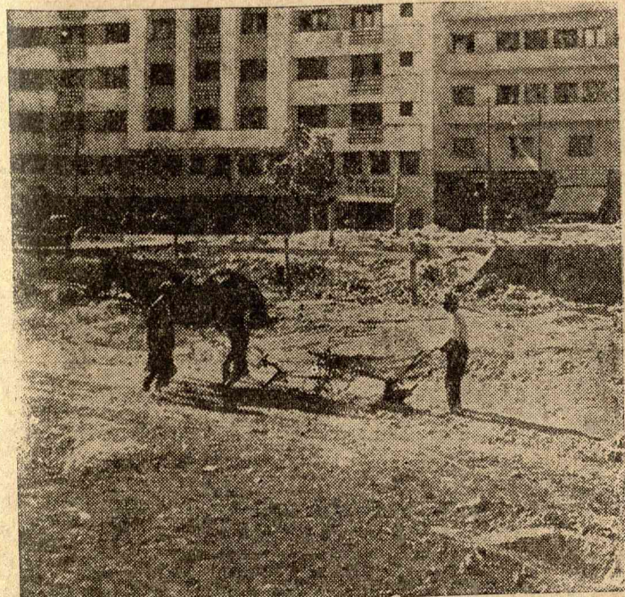
Ekével szántják fel a beton utburkolatot. Az eke élé fogott lovak csak nagy erőfeszítéssel húzzák a beton alapot feltépő ekét. A háttérben a belügyminisztérium hatalmas, új, betonból, acélból és üvegből készült palotája. A kép érdekessége, hogy a belügyminisztérium új palotája még nem is készült el, csak nagyszabású tervét szemlélteti televízió útján, mint kész épületet. A 24 millió lej költséggel felépítendő palota helyét szántják fel az eke élé fogott lovak.
