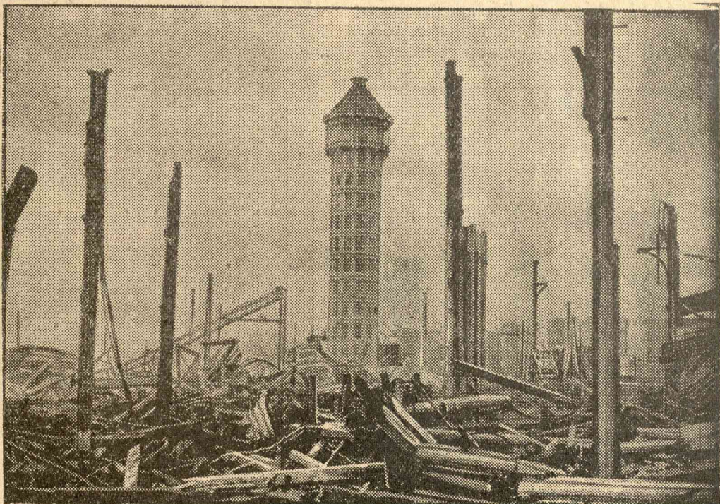
Kristály-palota leégés után. Elhajlott és összeolvadt vastraverzek néhány millió darab összegömbült és megolvadt üvegdarab jelzik csak a helyét a kétmillió fontot érő gyönyörű londoni kiállítási palotának.
