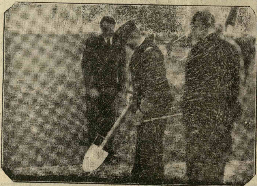
Kormányzó Úrunk ásóvágásával megkezdődött a Sajó-csatorna építése
