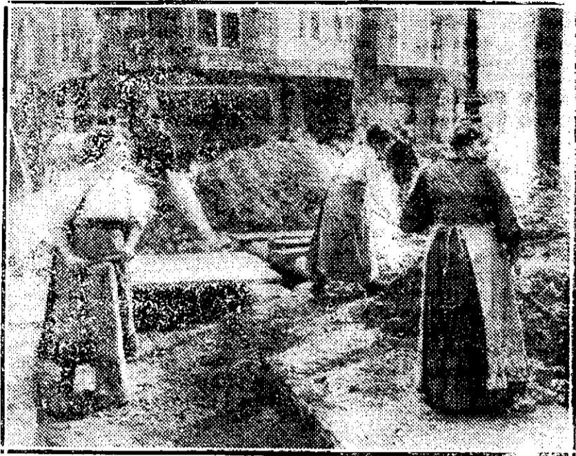
Femei muncind la lucrările unui tramvai subteran din Berlin
