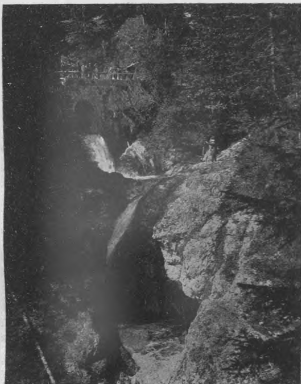
15. kép. A Chorinszky-gát zúgó felőli része.
