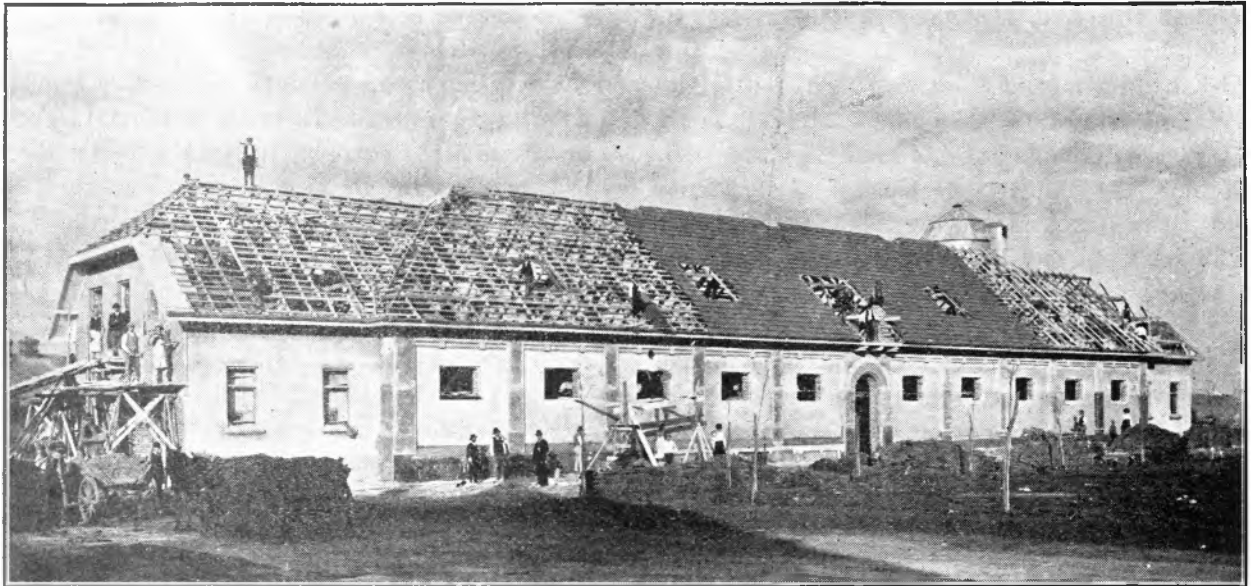
Acoperirea Grajdului de vaci dela Ferma Băneasa.
