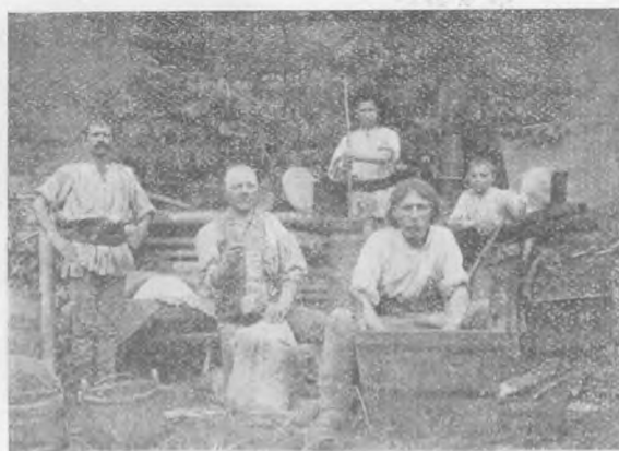
Aranjamentul unei stâne
