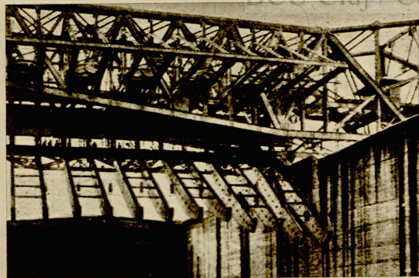
Un sector din marile instalații de golire și umplere a ecluziilor, care funcționează prin curent electric.
