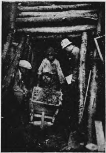
Săparea tunelului pentru localizarea focului.
