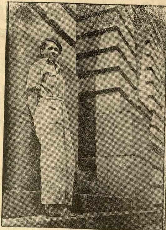
Finn munkás a stadion építkezésénél.
