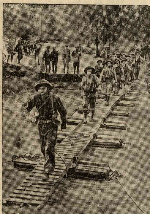
RÉSZLET AZ ANGOL NAGYGYAKORLATOKBÓL. Angliában nagyarányú katonai gyakorlatok kezdődtek. Mint láthatjuk, keskeny ponton hidakat alkalmaznak patakok és kisebb folyók áthidalására.
