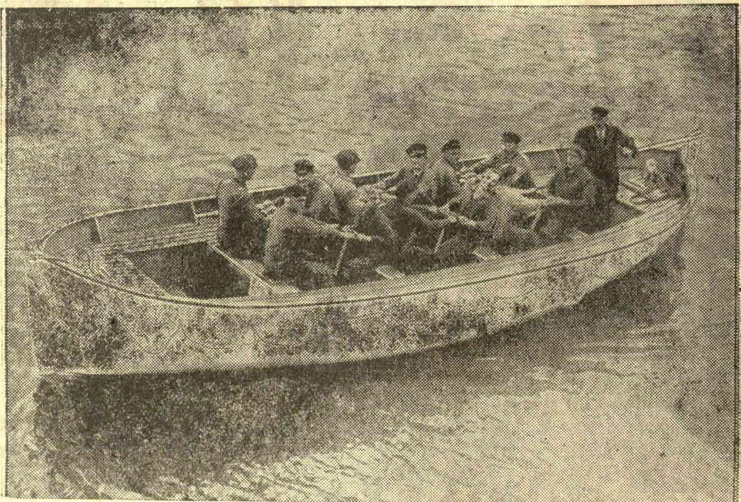
MENTŐCSÓNAK KÉZI HAJTÓSZERKEZETTEL. A német haditengerészet legújabb találmányát, az 53 személyt befogadó ujszerű mentőcsónakot mutatjuk be, amelyet hat ember kézi hajtóerővel 4.6 tengeri mérföldes sebességgel hajthat óránként.
