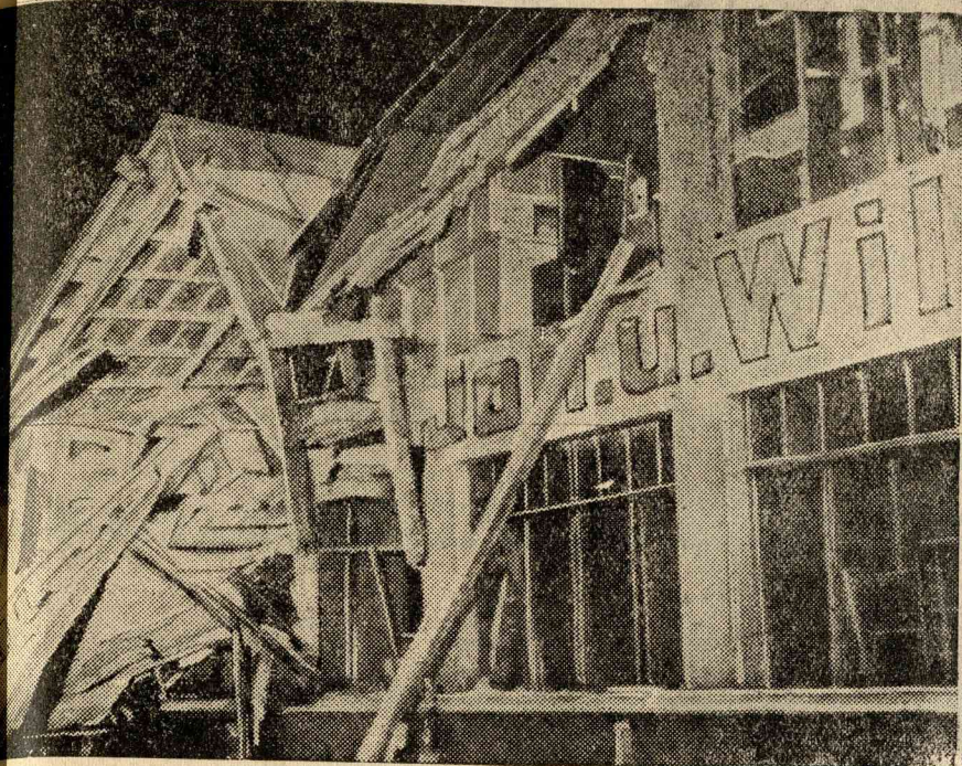
földcsuszamlás a Moseli völgyben. A Moseli völgyben földcsuszamlás. Ennek következtében több ház súlyosan megrongálódott. Képünk két elhagyott épületet mutat be.
