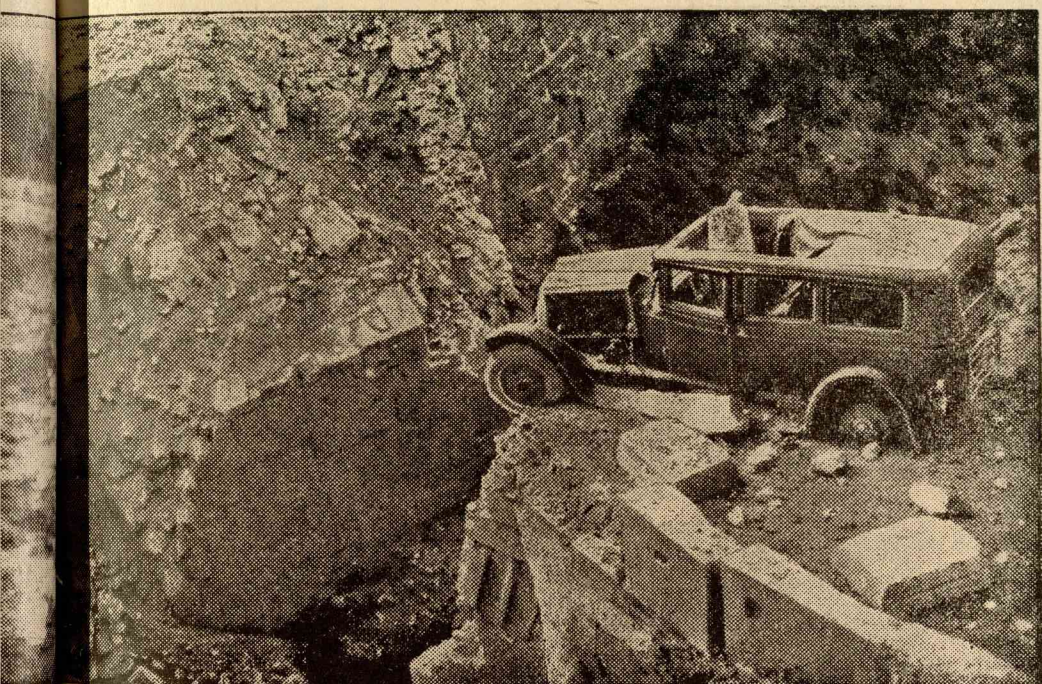
Szétrobbantott hid a Santander felé vezető uton.
