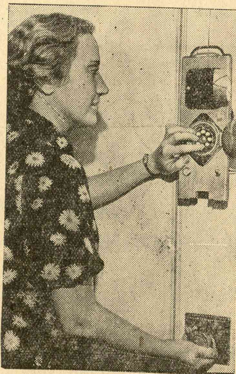
A kulcsnélküli zár. Edmond Michel francia elektrotechnikus új zárat talált ki, amely csak akkor nyílik ki, ha a záron elhelyezett számsor gombjait bizonyos előremeghatározott sorrendben megnyomják. Ha a sorrendet nem tartja be a bemenni akaró, a zár azonnal csengővel jelzi, hogy illetéktelenek babrálnak rajta.
