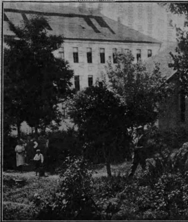
Infirmeria de izolare.
