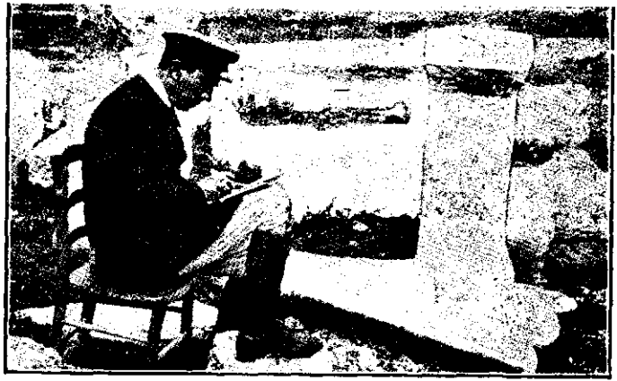
V. Pârvan pe șantier
