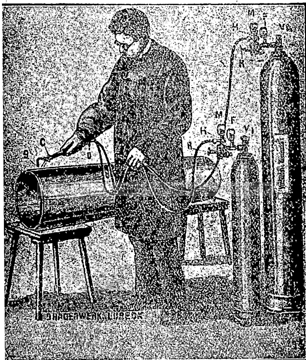
Fig. 5. Instalațiuni și execuție de sudură autogenă cu suflai ox-hidric.
