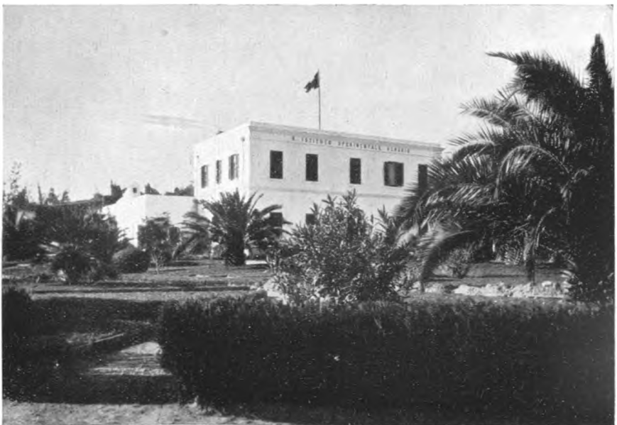
La sede centrale dell'Istituto Sperimentale Agrario in Sidi Mesri
