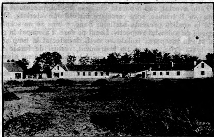
Fig. 1. — Clădirea Stațiunii pentru ameliorarea cerealelor.
