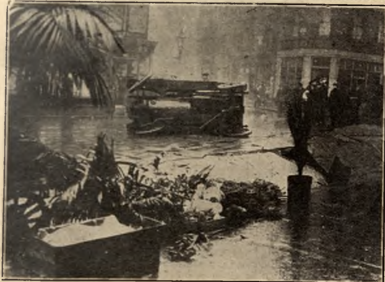
Un tub de oxigen subteran, instalat sub asfalt a explodat săptămâna trecută la Londra. Explozia a fost atât de puternică, încât a distrus pavajul, pe o distanță de 12 km. Clișeul nostru reprezintă o porțiune distrusă din pavaj și o mașină răsturnată de puterea exploziei.
