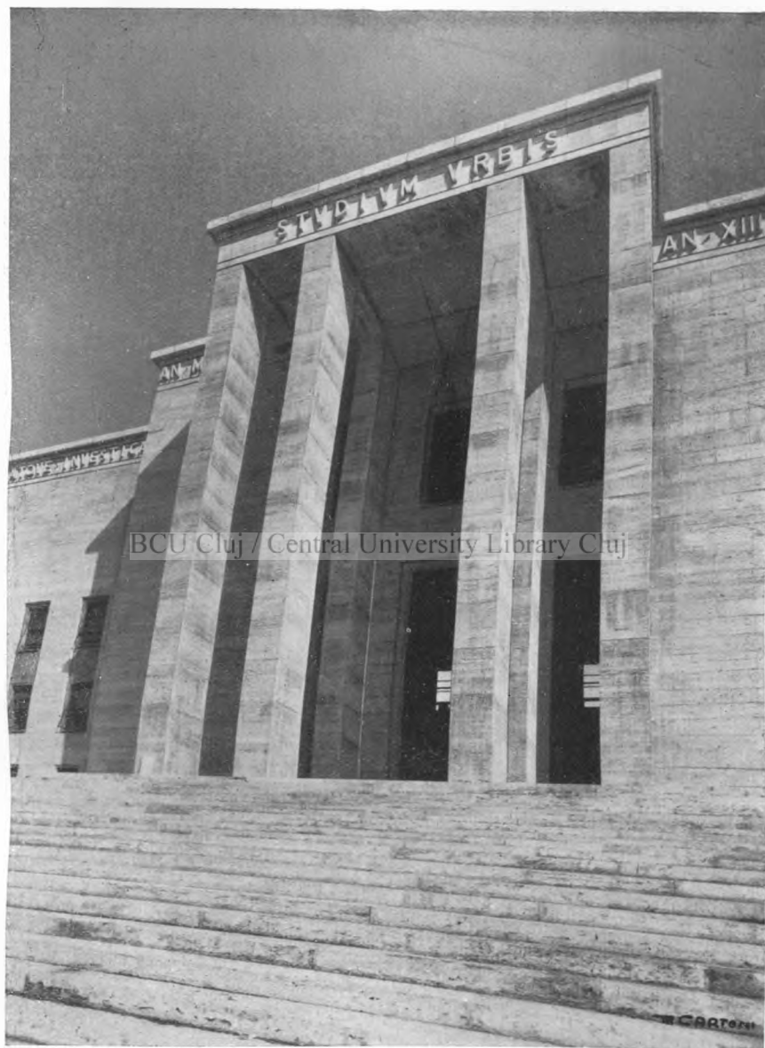
M. PIACENTINI : L'edifizio centrale della Città Universitaria
