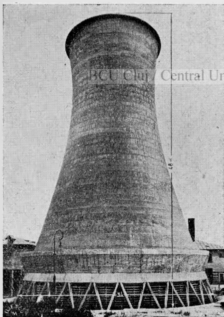
Fig. 1. — Noul turn de răcire a apei pentru condensatorii turbinelor uzinii Grozăvești.
