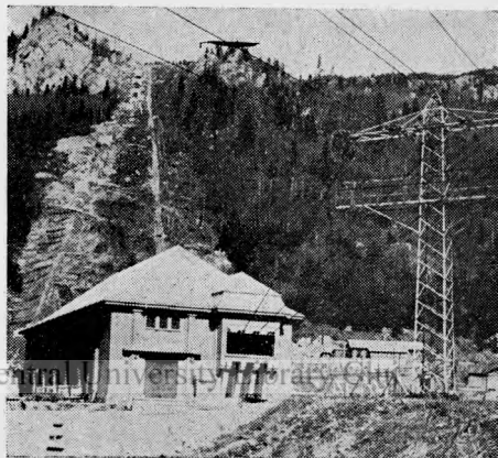
Fig. 3. — Uzina electrică Dobrești
