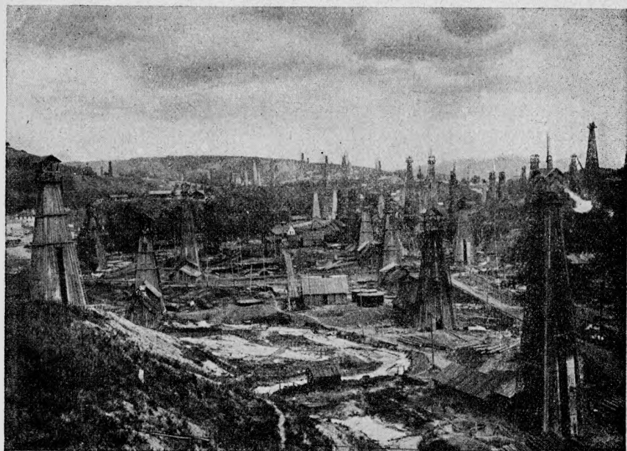
Vederea generală a șantierului Moreni-Pâscov
