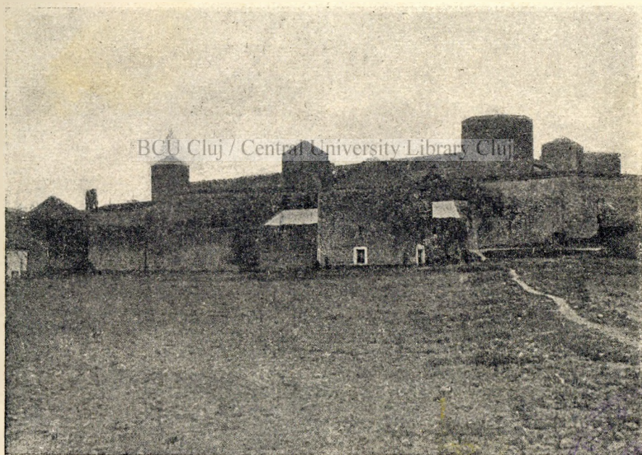
Vedere luată de pe malul de jos al Nistrului din cuprinsul lucrărilor exterioare ale Cetății de pământ (bastionata) asupra laturilor răsăriteană și nordică a Cetății de piatră.
