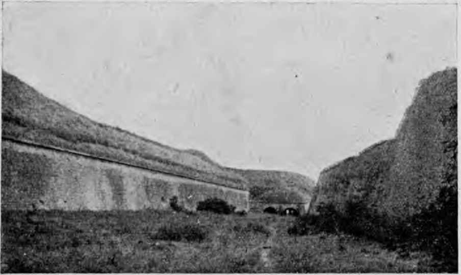
Fig. 5. Vederea șanțului Cetății bastionate, luat din latura sudică.
