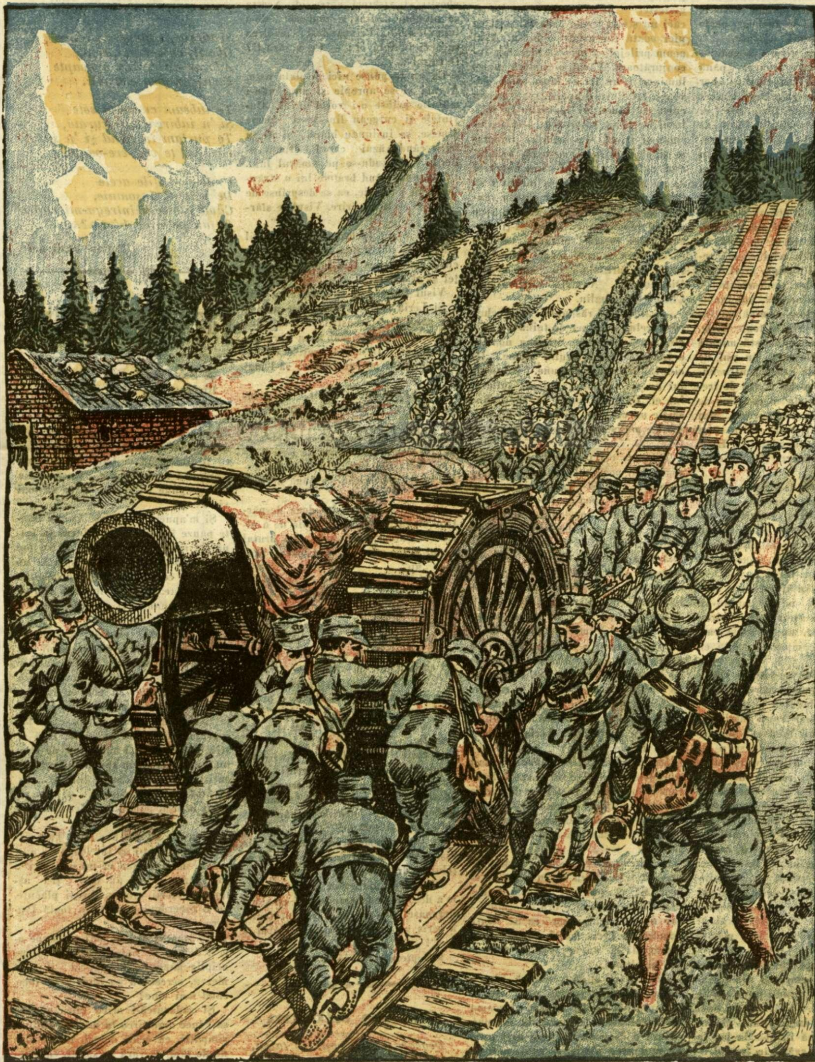
ACȚIUNEA ARMATEI ITALIANE. — TRANSPORTAREA TUNURILOR GRELE IN ALPI.
