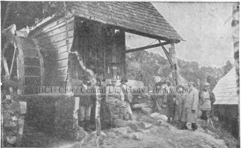
FIG. 7. — „Șteamp“-Moulin paysan à eau pour l'extraction de l'or, à Roșia Montana, M ts Apuseni (A gauche les paysans propriétaires).
