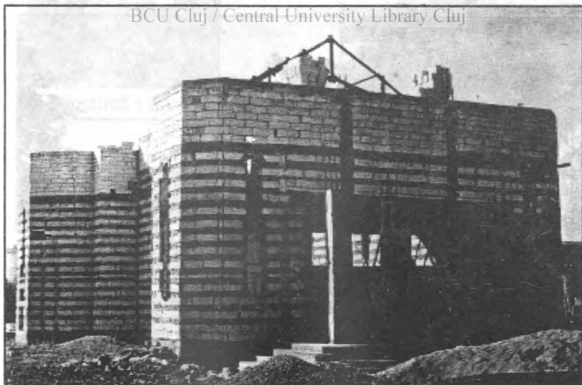
Noua Biserică Ortodoxă în construcție
