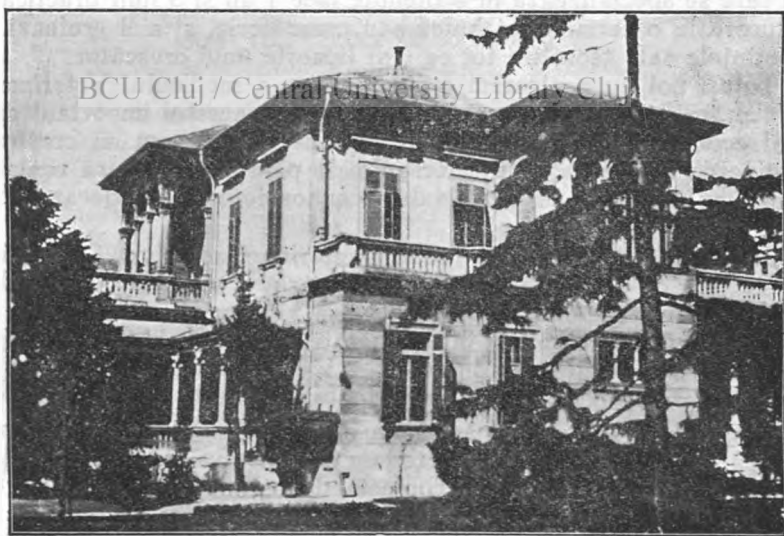
Fig. 1. Clădirea principală cu laboratoarele stațiunii.
