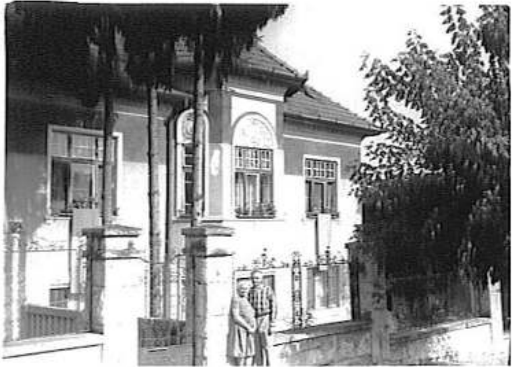
• Casa familiei Balotă din Cluj, strada Bolinteanu, 26
