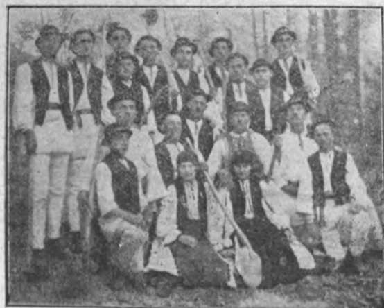
Foarte harnicii legionari din Nucet (jud. Sibiu) fotografiați, după muncă, pe drumul construit de ei cu mare trudă.
