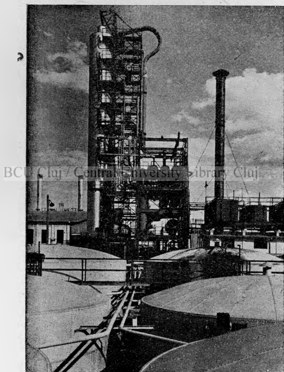
Fig. 1. Instalație modernă de distilare, tubulară, ( Pipe still ) distilă 160 vagoane pe zi. Rafinăria Creditul Minier Brazi .
