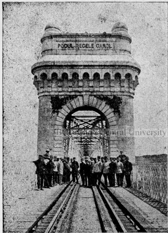
Fig. 37. Portalul podului peste Dunăre de pe malul opus Cernavodei.
