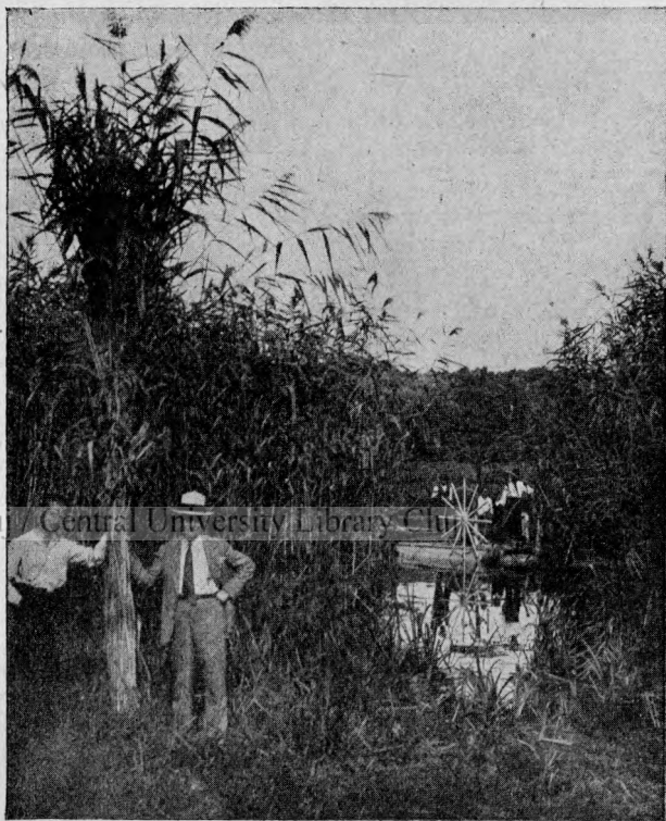
Fig. 3. — Deschiderea unui canal de 4 m. lățime. În planul întâi se pot vedea dimensiunile plantelor tăiate. În fund mașina de tăiat.
