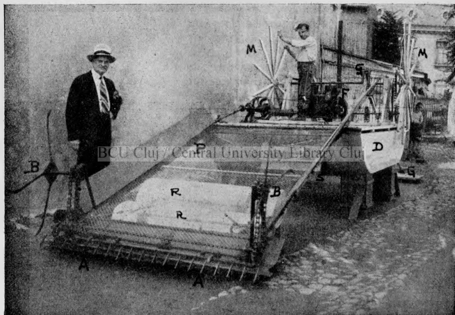
Fig. 1. — Mașină pentru curățat bălțile de plantele acvatice. — AA. aparatul de tăiat orizontal. — BB. cuțitele laterale verticale. — P. pod basculant. — RR. rezervoare de aer. — S. sbaturi. — MM. roate de manevră. — D. barcă. — GG. brațe de propulsie. — F. motor.
