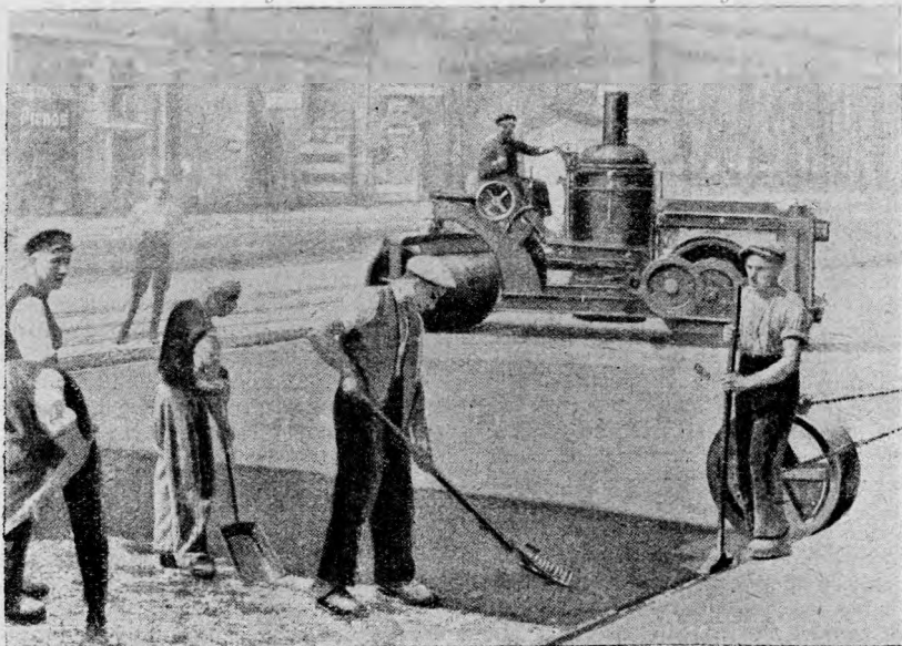
Fig. 3. Construcția unei străzi de asfalt bătătorit pentru trafic greu.
