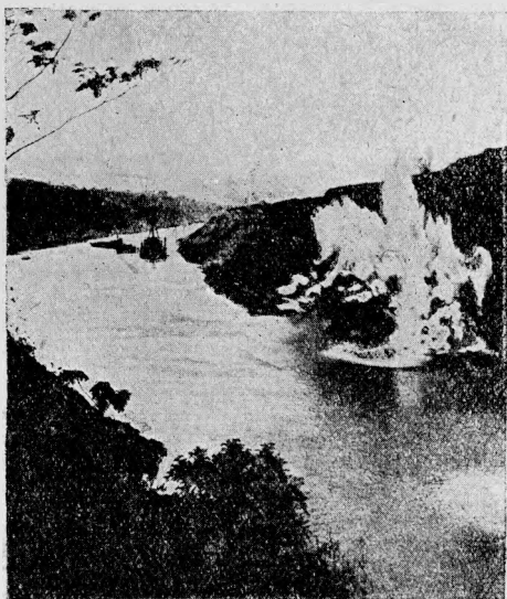
Fig. 9. Se mai lucrează și azi în unele locuri unde terenul se surpă sau unde e nevoie de o adâncire a canalului. (După o fotografie).
