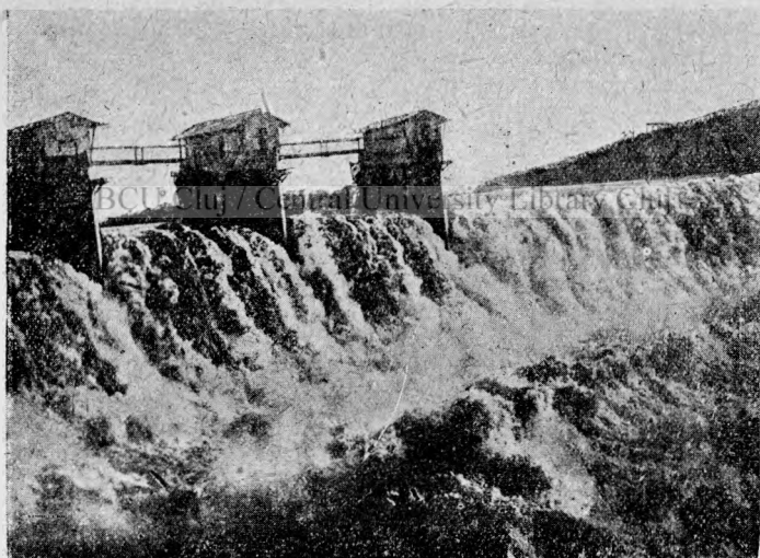
Fig. 1. Barajul dela Gatun . Apele, ajunse la nivelul superior, se varsă din lacul Gatun în fluviul Charges . (După M. King «Views of the Panama Canal»).
