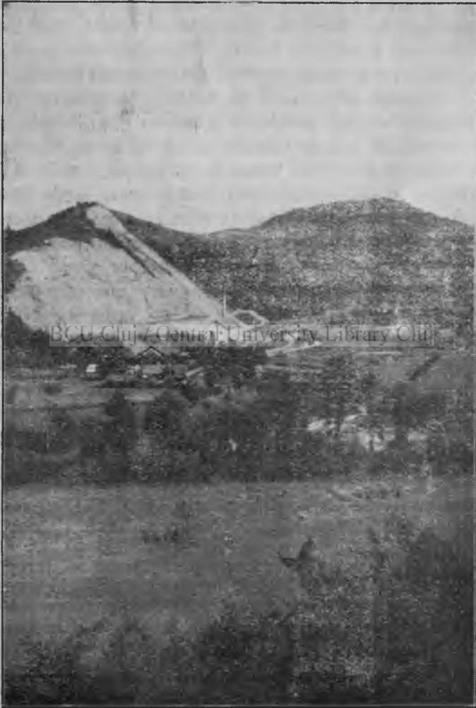
Cariera de andezit din Vârfurile deschisă la 1895 și provăzută cu trei concasori; de prezent se montează o nouă instalație de sfărmat piatra.
