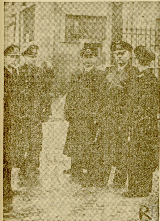
Inspectarea fortificațiilor Atlanticului
