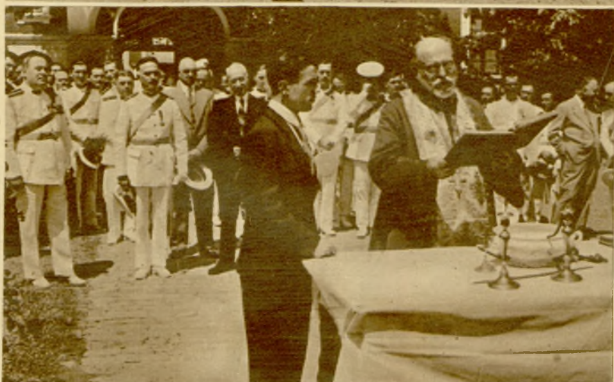
Sfințirea monumentului eroilor dela Arsenal. În timpul pomenirii morților.
