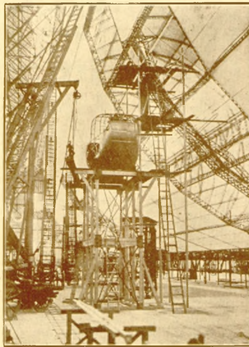
Urișa navă aeriană, aproape de terminare.
