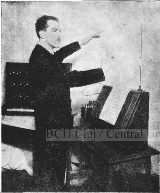
Profesorul Theremin din Petrograd (Leningrad) în fața instrumentului său electric, cântând o serenadă. Cu mâna dreaptă se produce înălțimea sunetului, iar cu cea stângă se dirijează tăria sunetului.
