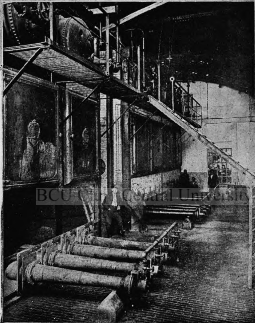
Căldările uriașe în care se arde gaz metan și se produc vapori pentru turbina de trei mii cai putere.
